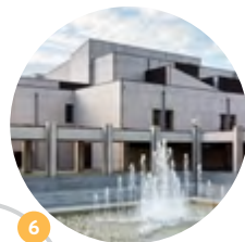
6 O Fórum Maia é o centro de cultura e congressos do concelho. Projetado por José Carlos Loureiro, o edifício conta com um grande conjunto de serviços e evidencia-se pela suas linhas retilíneas.
