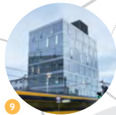
9 O Maia Trade Center , do arquiteto João Álvaro Rocha, alberga vários serviços e forma uma porta de entrada na cidade, dada a sua proximidade com o metro.
